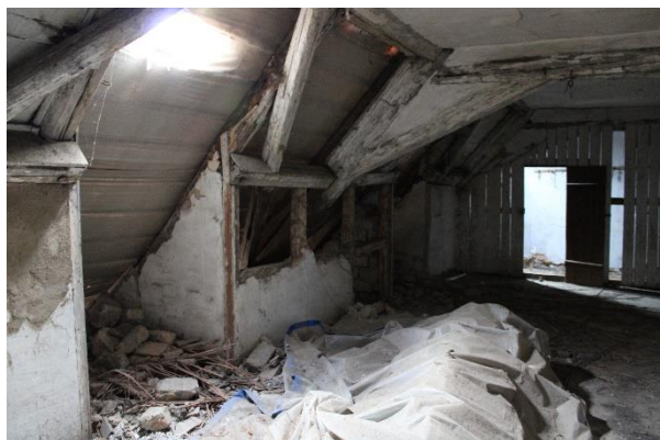
Abbildung 25: Dachgeschoss kommunaler Bauhof
