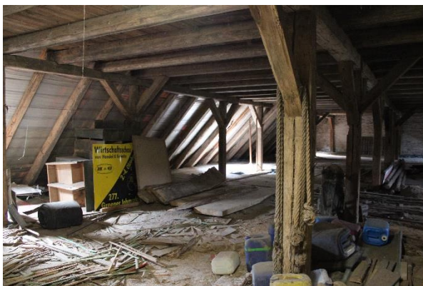
Abbildung 24: Dachgeschoss kommunaler Bauhof
