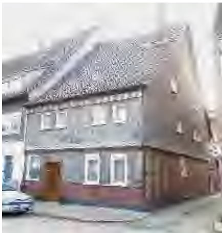
Gebäude Baustraße 14 mit vorkragendem Obergeschoss (Foto links). Ensemble Gebäude Baustraße 22-20 mit Vorkragungen im Übergang zum Dachgeschoss.
