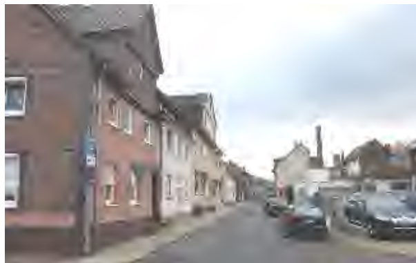
Gebäudegruppe Backofenstraße 46 bis 34
