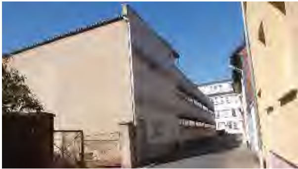
Parkhaus Eckbereich Backofenstraße/Schäfergasse
