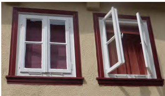
Fenster ohne Kämpfer im 6-Scheiben-Bild. Linkes Beispiel zweiflügelig nach außen, rechtes Fotobeispiel zweiflügelig nach innen öffnend (sog. Stülpfügel Fenster).
