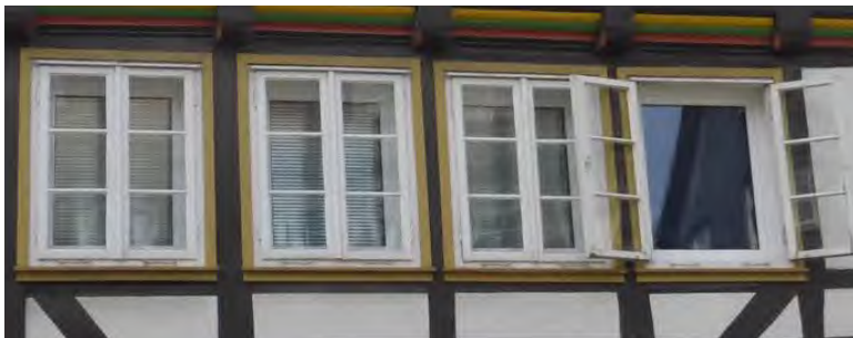
Fenster ohne Kämpfer im 6-Scheiben-Bild. Linkes Beispiel zweiflügelig nach außen, rechtes Fotobeispiel zweiflügelig nach innen öffnend (sog. Stülpfügel Fenster).
