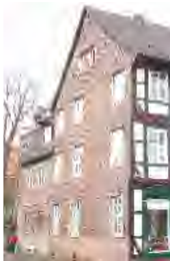
Gebäude Benser Straße 21 (Foto links) mit Sandsteingiebel und Gebäude Benser Straße 31 mit Naturschieferfassade traufseitig und Sandsteinbehang giebelseitig.
