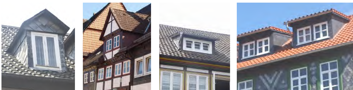
Von links nach rechts: Satteldachgaube, Walmdachgaube, Schleppdachgaube, Dreiecksgaube.
