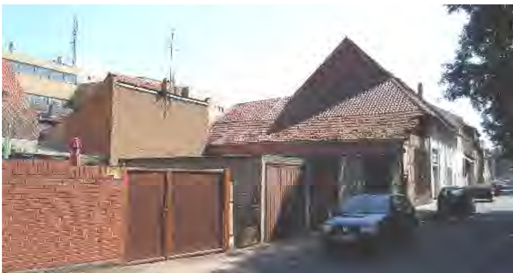
Bereich entlang der Hägermauer
