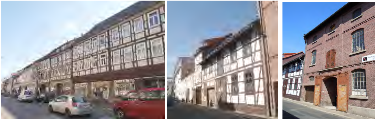
Altendorfer Str. 20-30: dreigeschossiges Gruppendenkmal. Backofenstraße teils von Wirtschaftsgebäuden geprägt (Fotos rechts).
