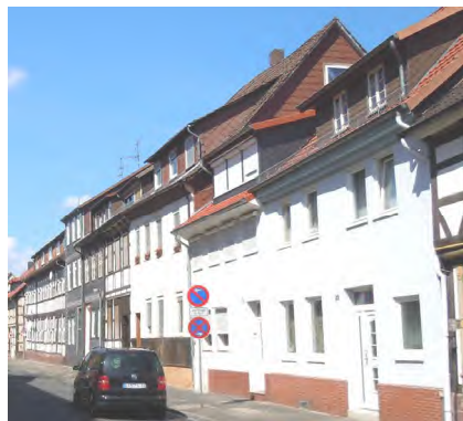
Gebäudegruppe Baustraße 35 bis 23
