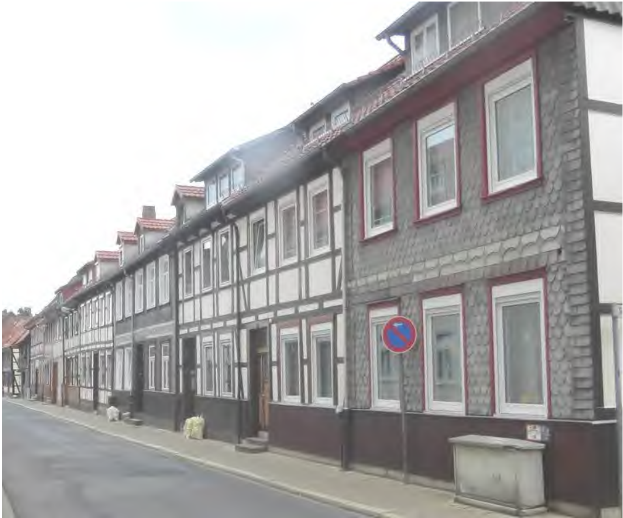
Backofenstraße: Drei Doppelhauspaare in Sichtfachwerk, neben Schieferfassaden.
