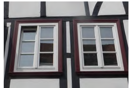
Fenster ohne Kämpfer im 6-Scheiben-Bild. Linkes Beispiel zweiflügelig nach außen, rechtes Fotobeispiel zweiflügelig nach innen öffnend (sog. Stülpfügel Fenster).
