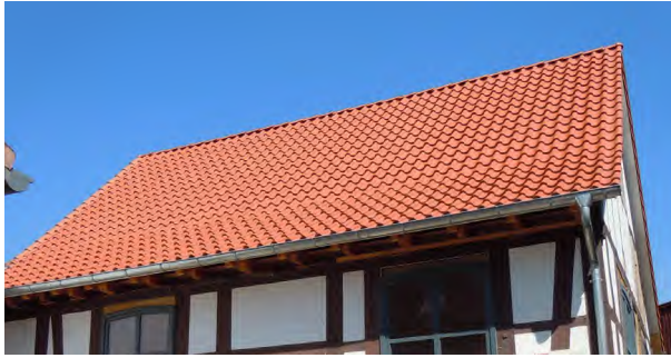
Beispiele Eindeckung mit naturroten S-/Hohlfalzziegeln und Beispiel Satteldachgauben (Foto rechts).
