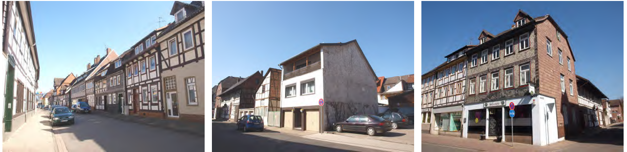
Baustraße 2-12: zweigeschossige geschlossene Quartiersrandbebauung, Gebäude Benser Mauer (Bild Mitte). Dreigeschossiges Gebäude Benser Straße 31 mit Schieferfassade traufseits, Sandsteinbehang giebelseits (Foto ganz rechts).
