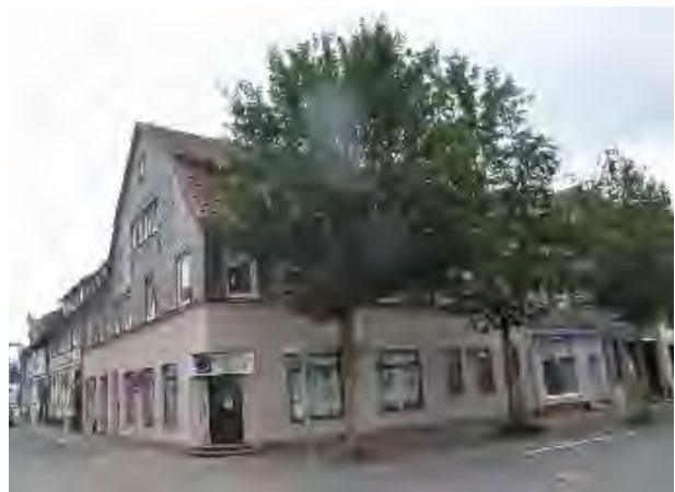
Eckbereich Benser Straße 7/Backofenstraße - mit Mansarddach wie Benser Straße 23
