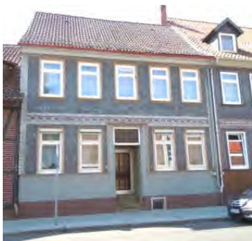
Flächenbündige Fachwerkbauten mit Naturschieferbehängen, z.B. Gebäude Hagerstraße 1 und 3 (Foto links und Mitte) und Gebäude Baustraße 19.
