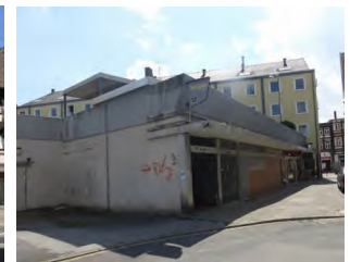
Flachdach zur Judenstraße
