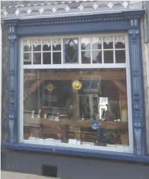
Beispiele traditioneller Schaufenstergestaltungen mit Lisenen, linkes Beispiel mit typischen Kassettenfüllungselementen im Eingangsbereich.
