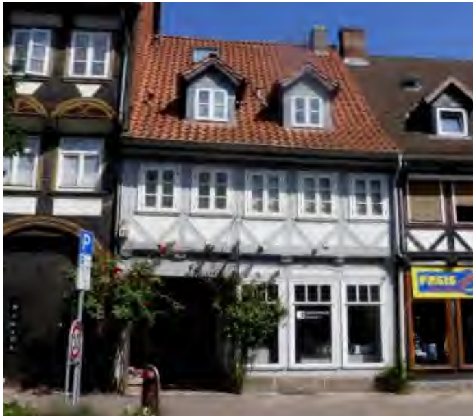
Beispiele von Fachwerkstrukturen mit Fußstrebenpaaren: Altendorfer Straße 31 und 33
