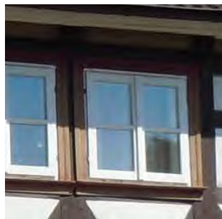
Fenster ohne Kämpfer im 6-Scheiben-Bild. Linkes Beispiel zweiflügelig nach außen, rechtes Fotobeispiel zweiflügelig nach innen öffnend (sog. Stülpfügel Fenster).
