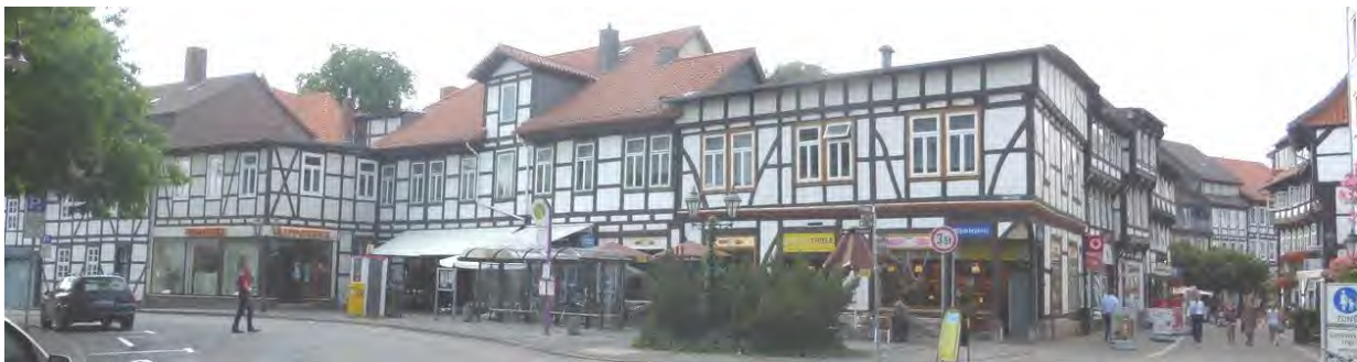
Bebauung zum Möncheplatz – Eckgebäude „Lange Brücke 12“, Hausgruppe „Lange Brücke 12-2“
