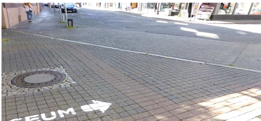
Tiedexer Straße/Marktplatz - nicht mehr zeitgemäßer und sanierungsbedürftiger Materialmix
