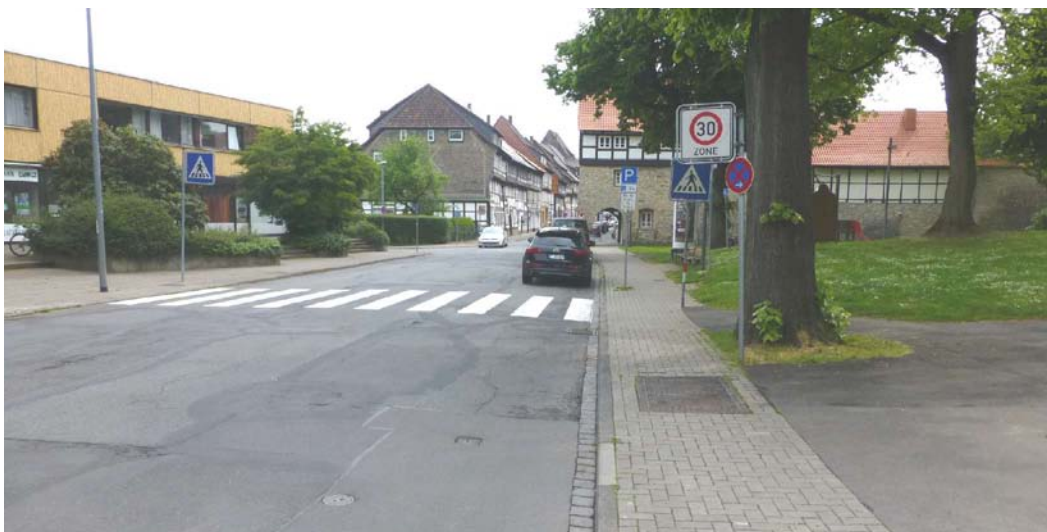
Tiedexer Tor – Sanierungsbedarf; Raumangebot für Fußgänger vergrößern
