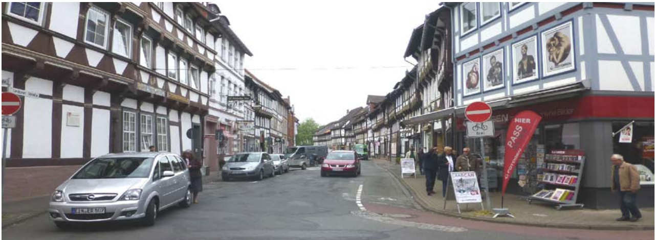
Straßenraum Tiedexer Straße – Sanierungs und Gestaltungsbedarf
